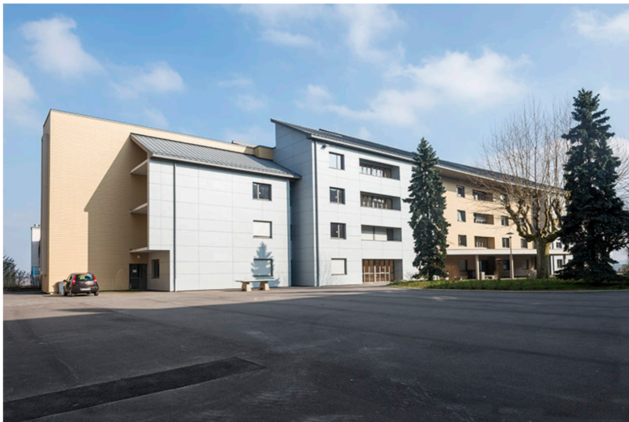
Angle nord-ouest et façade antérieure de l'internat de garçons.
