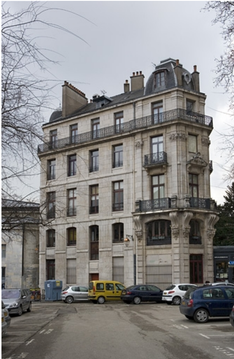
Vue d'ensemble de la façade sur la place du Théâtre, de trois quarts droit.
