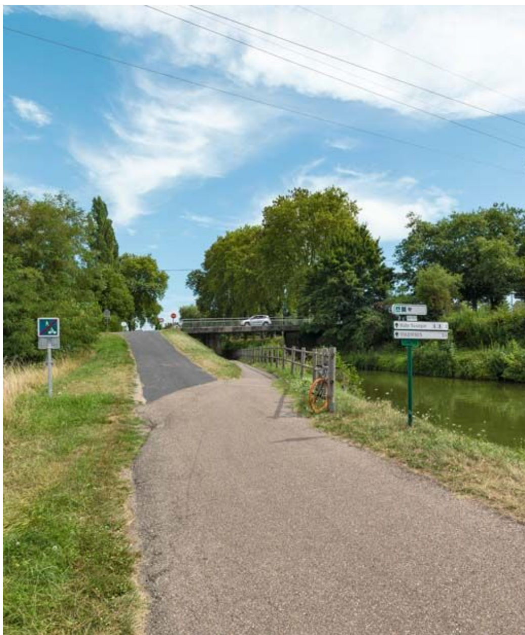
Vue d'ensemble du pont.
