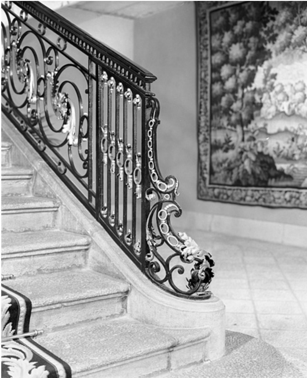
Intérieur, escalier : détail du départ de la rampe en ferronnerie.
