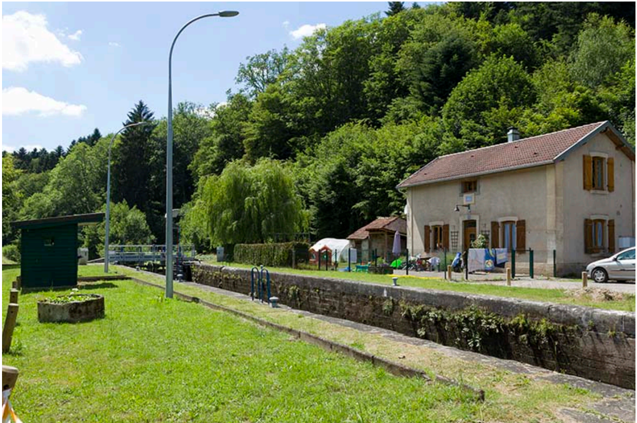
Le site d'écluse.
