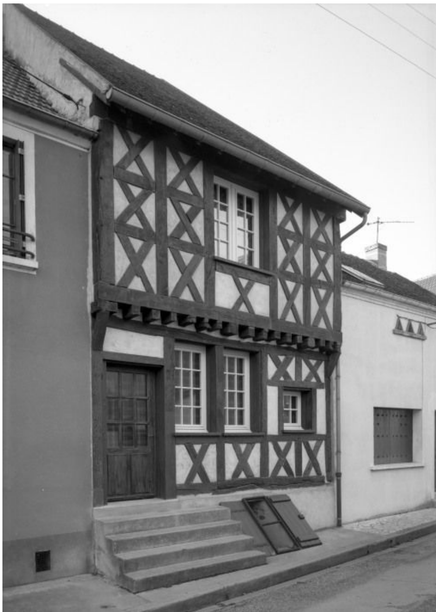
Maison située 4 rue de l'Hôpital (cada. 1977, sect. AC, parc. 215) : façade.
