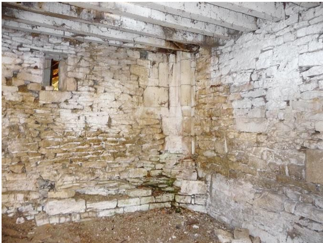
Chapelle, corps postérieur : vue de l'angle sud-ouest.
