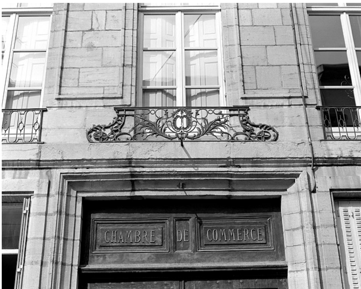
Façade antérieure, garde-corps de la fenêtre centrale.
