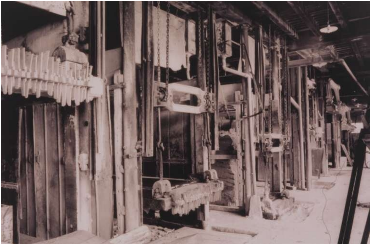
Vue d'ensemble des châssis multilames.
