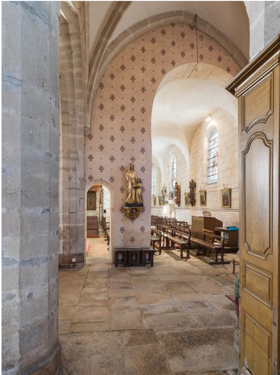
Arcades du mur ouest de la chapelle nord.
