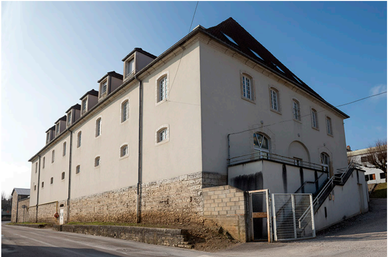
Bâtiment de restauration et internat de filles vus de la rue des carrières, à l'est.
