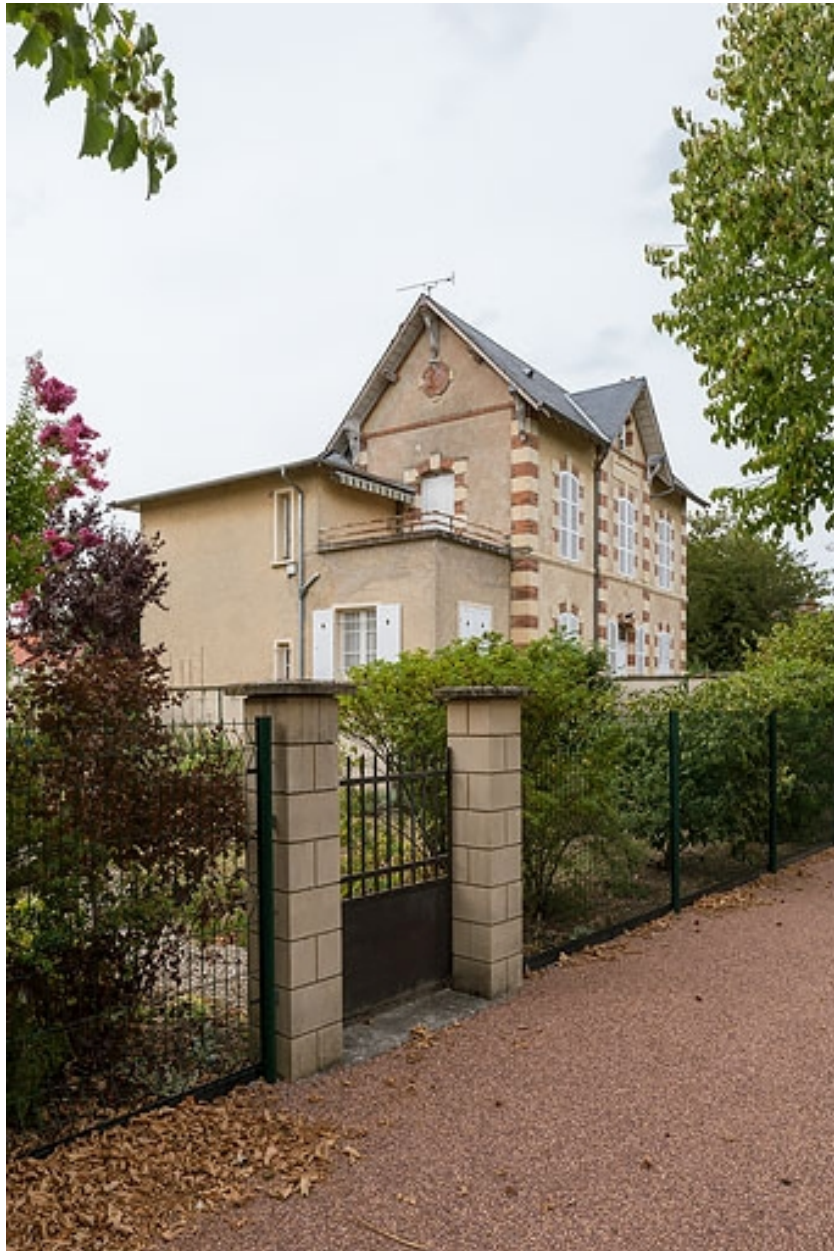
Vue de trois-quarts, depuis l'avenue du Casino.
