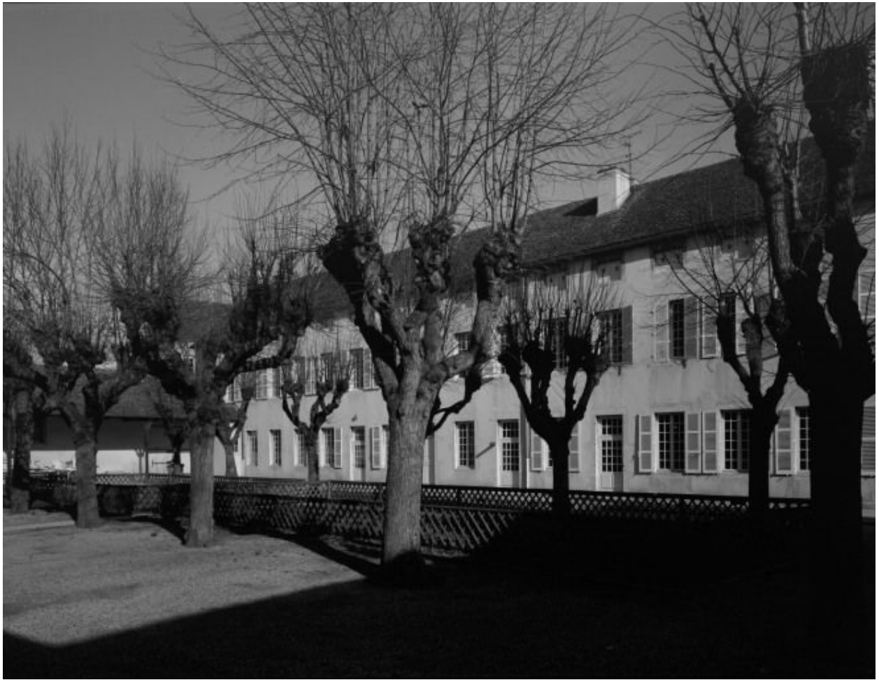
Bâtiment situé à l'est de la cour principale (services Sainte-Anne et Saint-Antoine)
