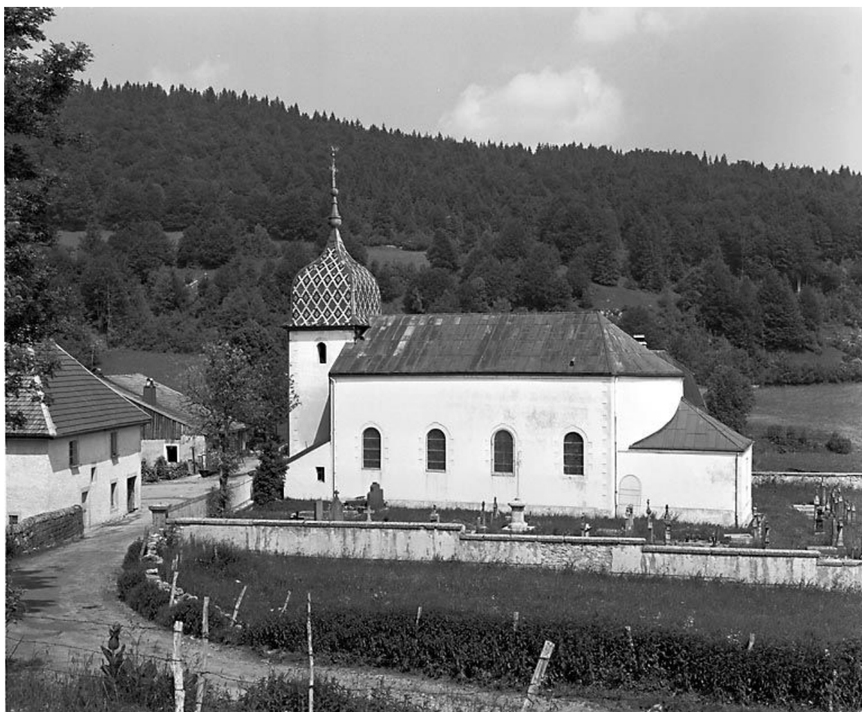
Façade latérale droite.
