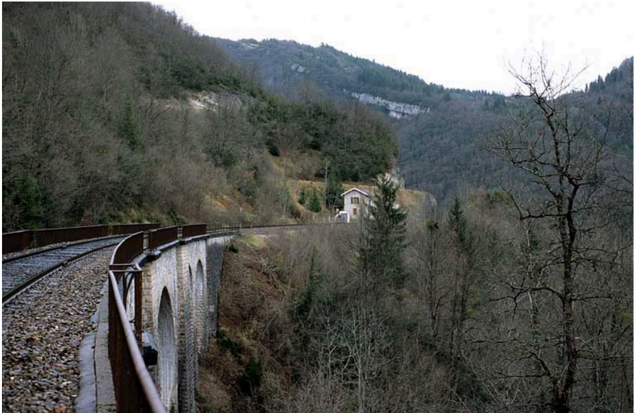
Extrémité du viaduc côté Andelot-en-Montagne, depuis le sud.
