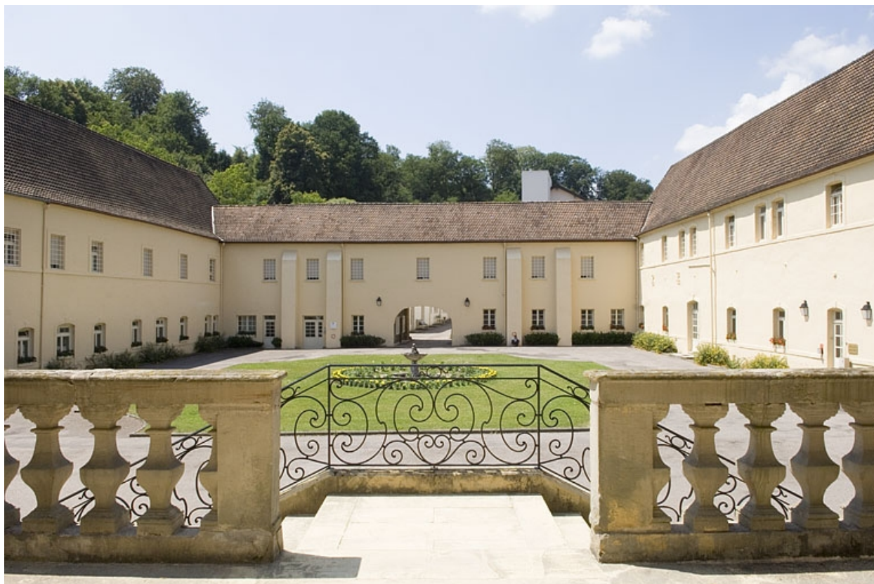
Bâtiments sur cour.
