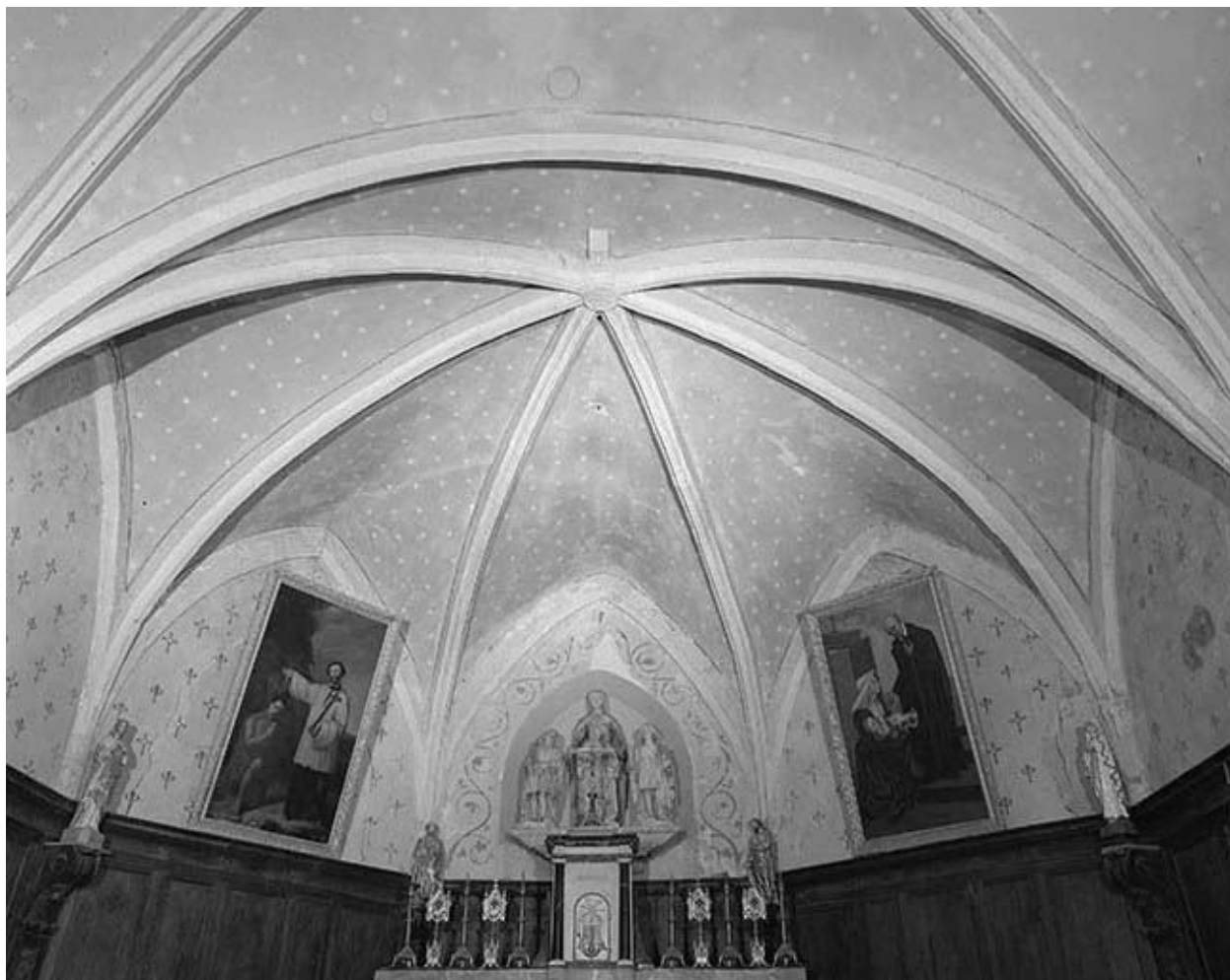
Intérieur : chœur, voûte de l'abside.
