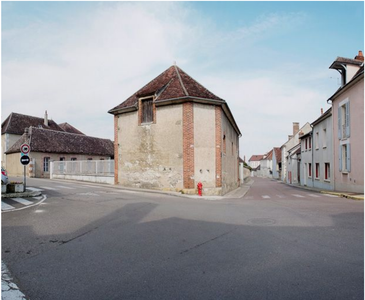
Anciennes dépendances, vue d'ensemble.
