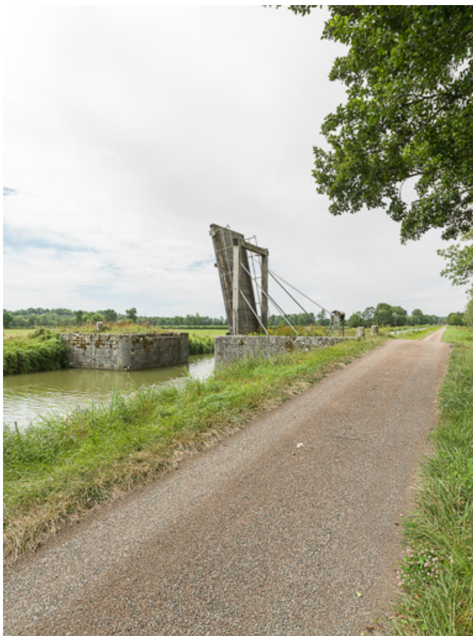
Vue d'ensemble du pont mobile, relevé.
