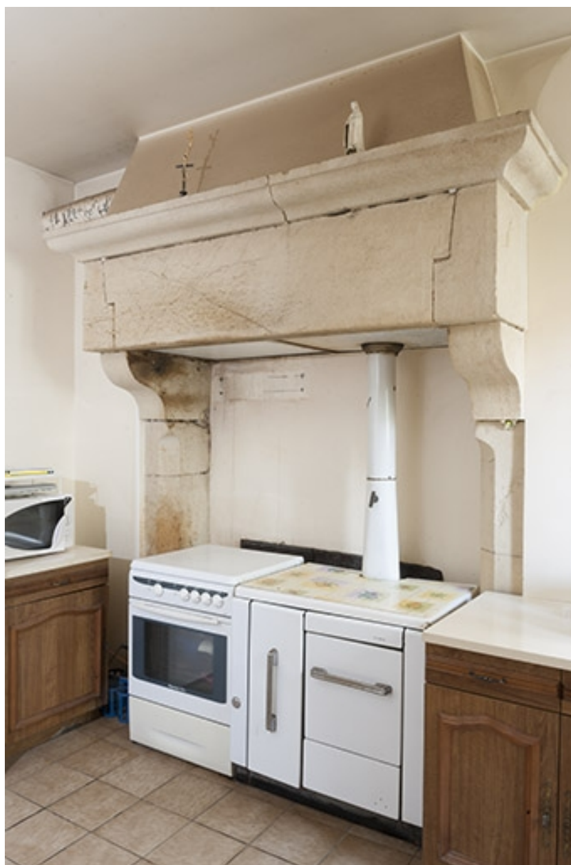
Cuisine : vue générale de la cheminée.
