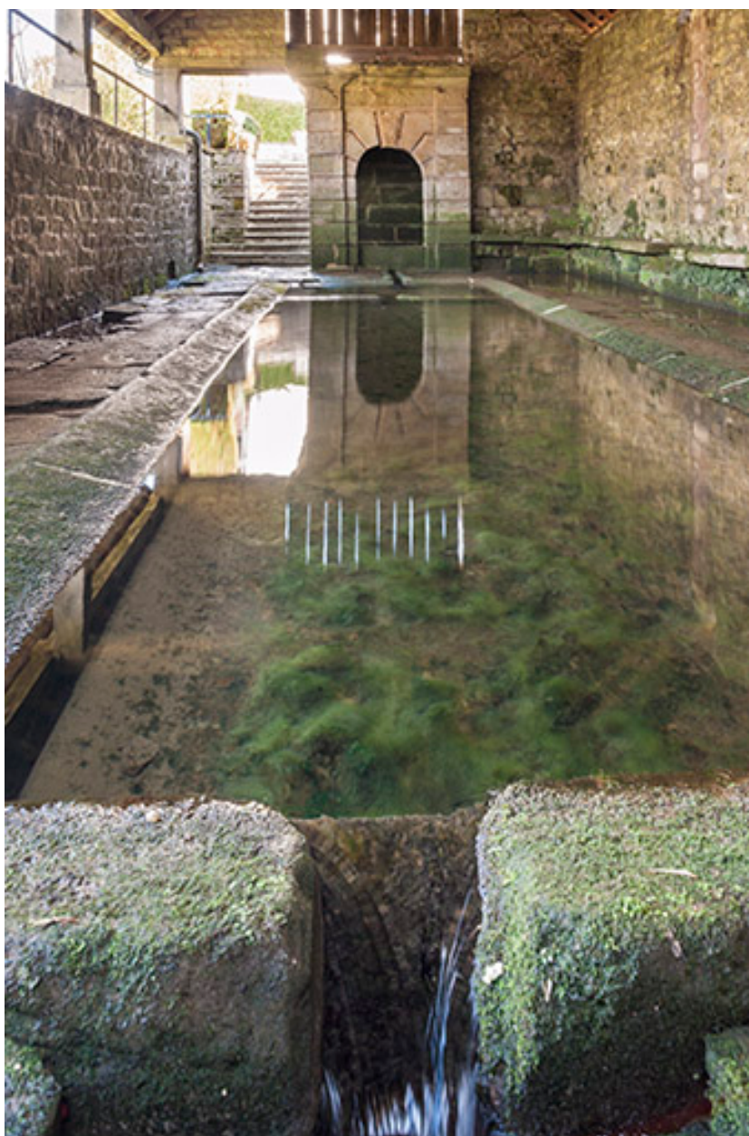
Le bassin et son déversoir.
