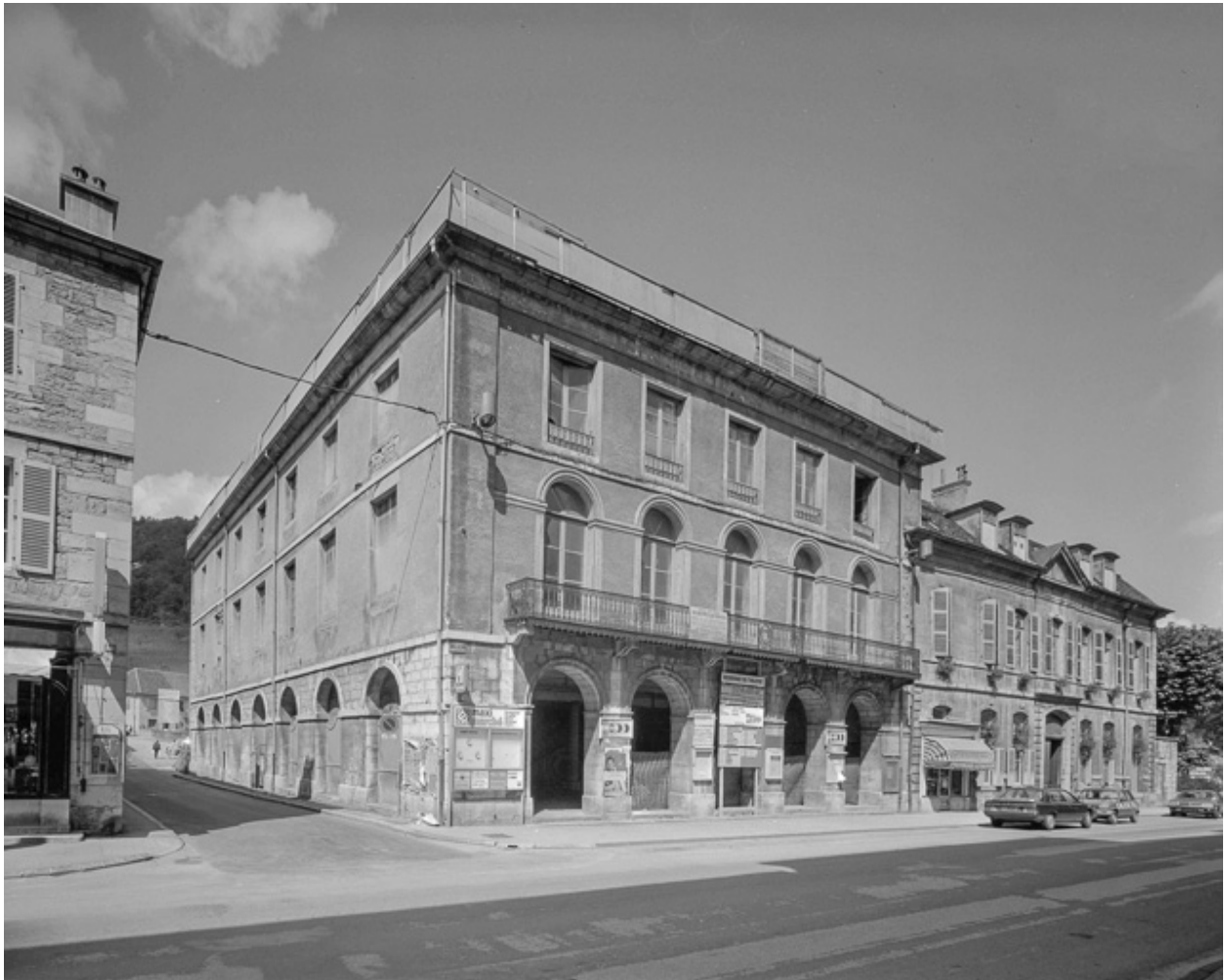
Vue avant déconstruction (1987).
