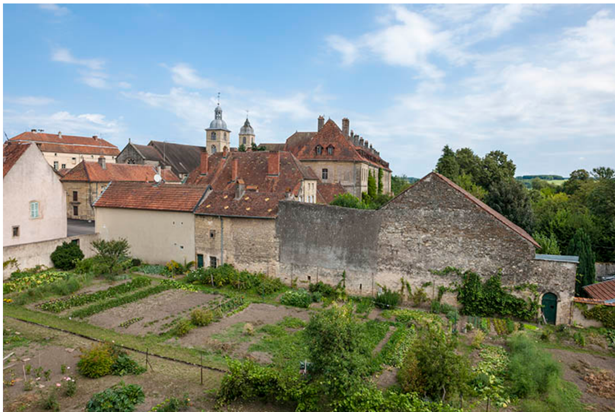
Vue générale depuis la rue Rollin
