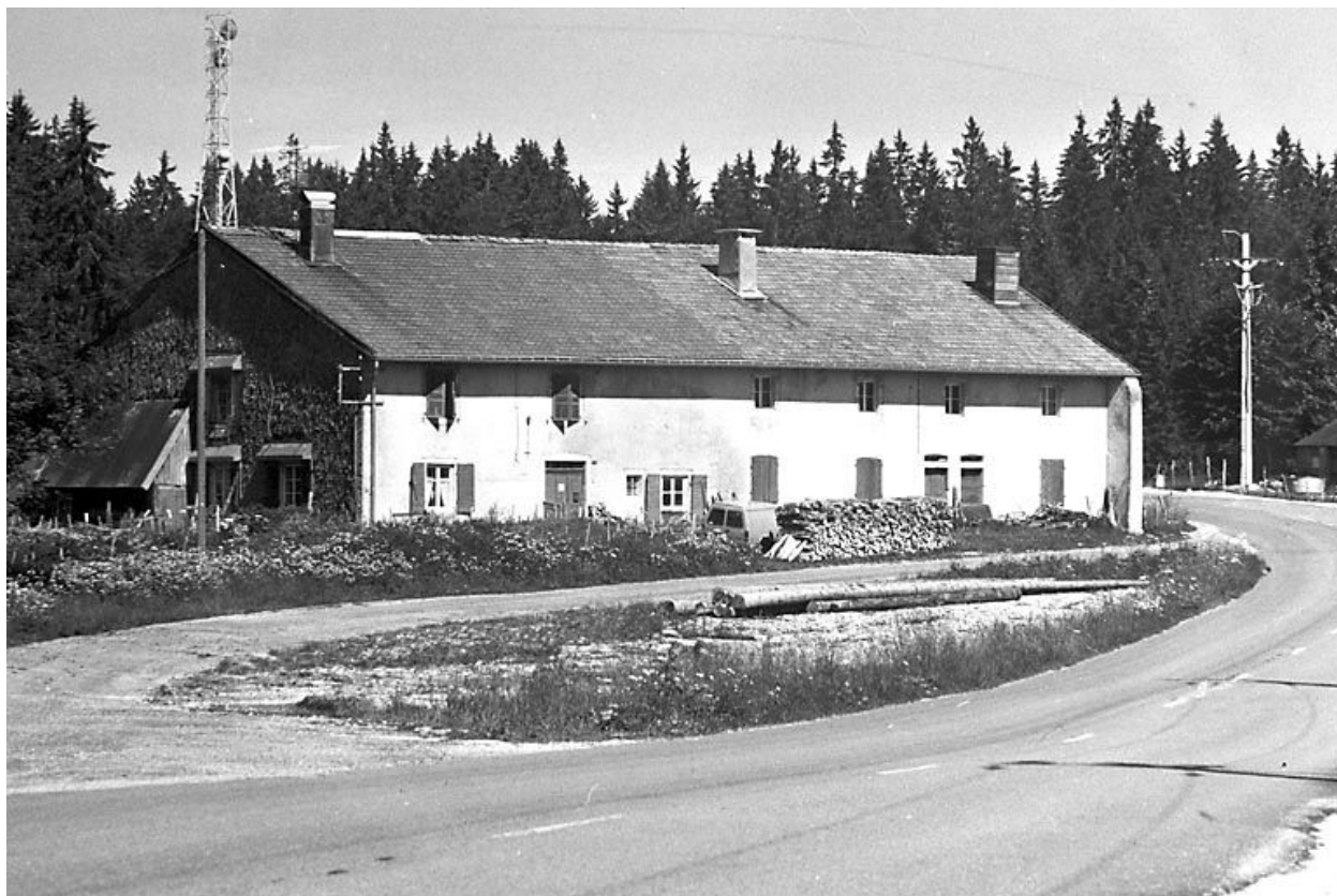
Vue éloignée de la façade antérieure.
