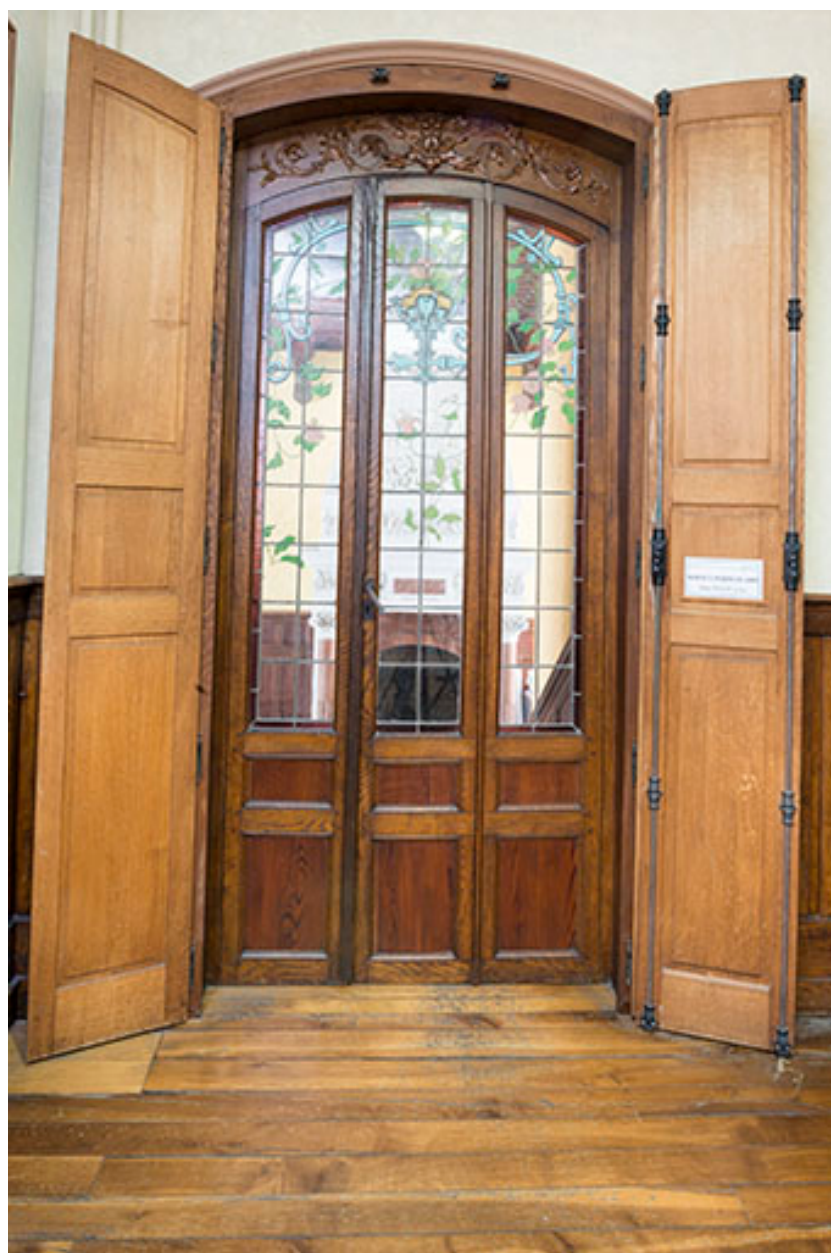
Porte d'accès vers la salle de bal.
