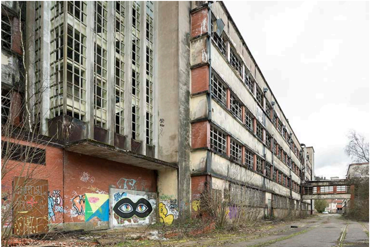
Etat en 2016. Usine A : façade nord du bâtiment de filature et tissage.
