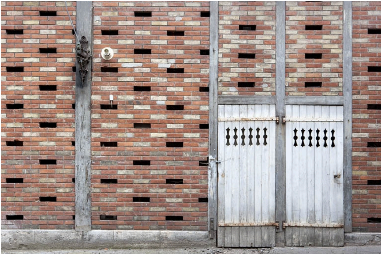
Détail de la façade en brique du bûcher.
