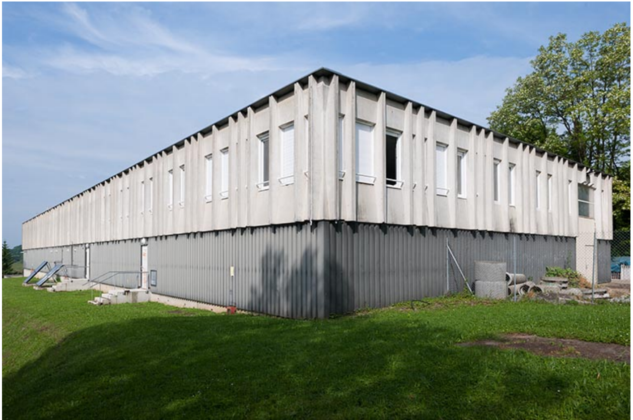
Angle nord-est, petit côté nord-est et longue façade sud-est de l'aile nord-est de l'externat.
