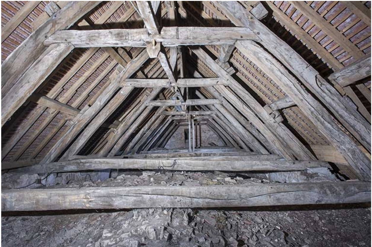
Vue d'ensemble de la charpente.
