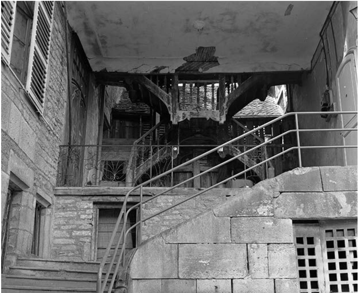
Maison (AB 58) 68 rue Pierre Vernier : escalier sur cour.
