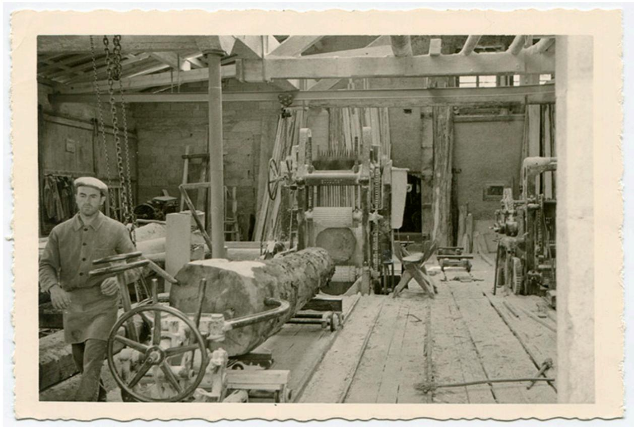
[Sciage au gros châssis de scie Socolst, vu depuis le fond de l'atelier : un tronc d'arbre est approché de la scie], années 1960.
