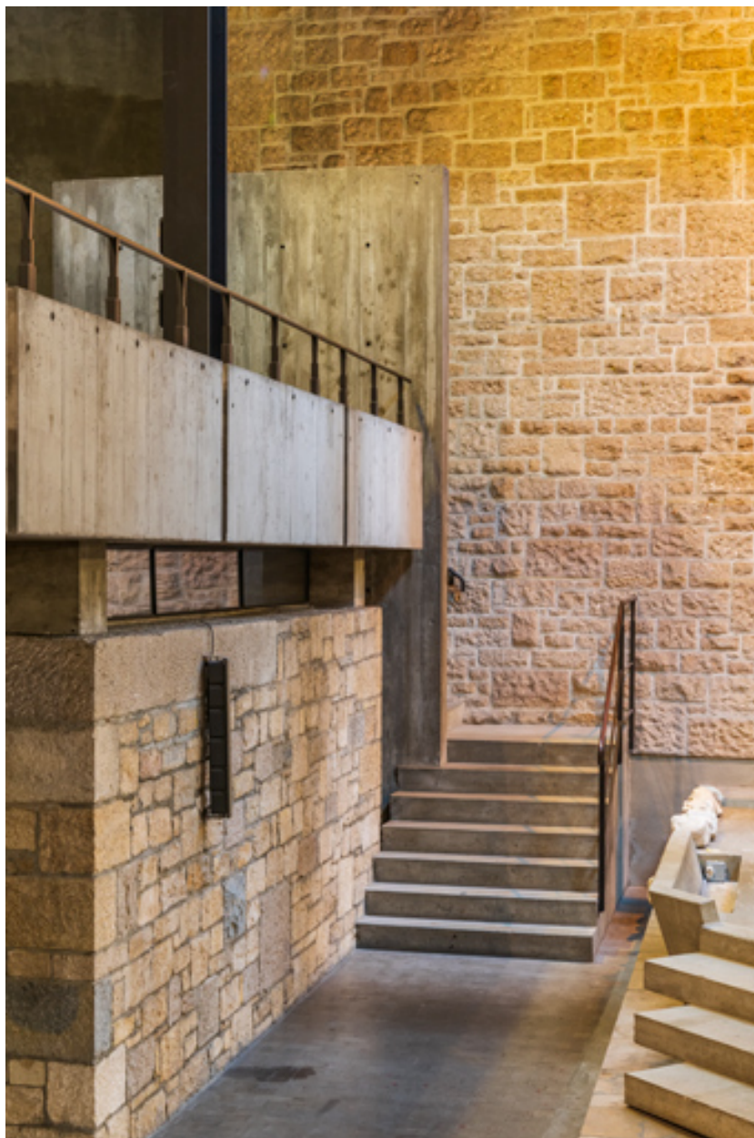
Escalier d'accès à la tribune ouest.
