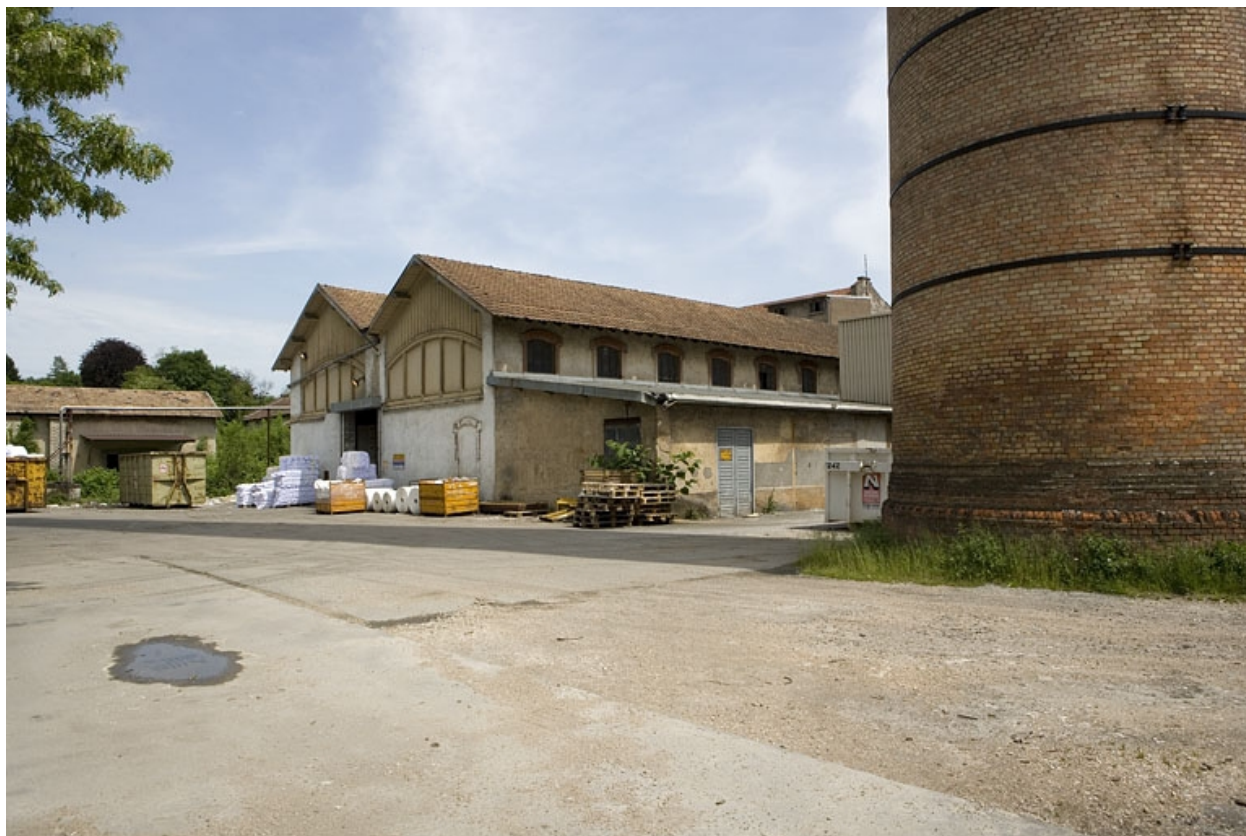
Entrepôt industriel. Pignon ouest.
