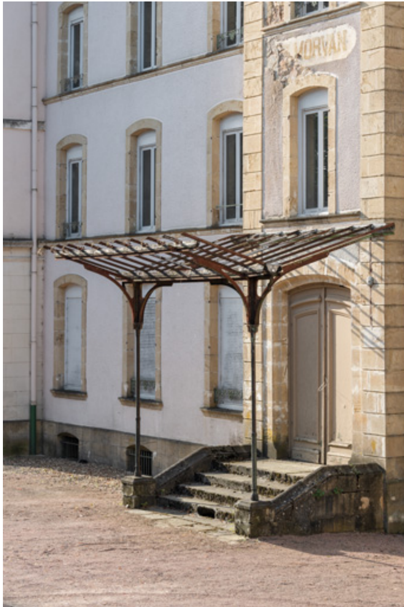
Marquise de la façade sur l'avenue.
