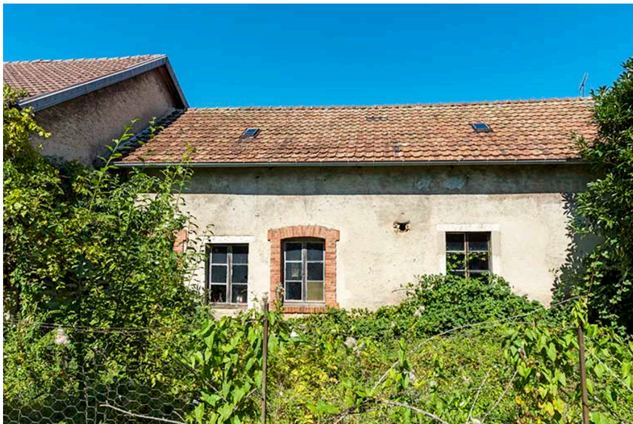
Anciennes grange et écurie : façade postérieure.
