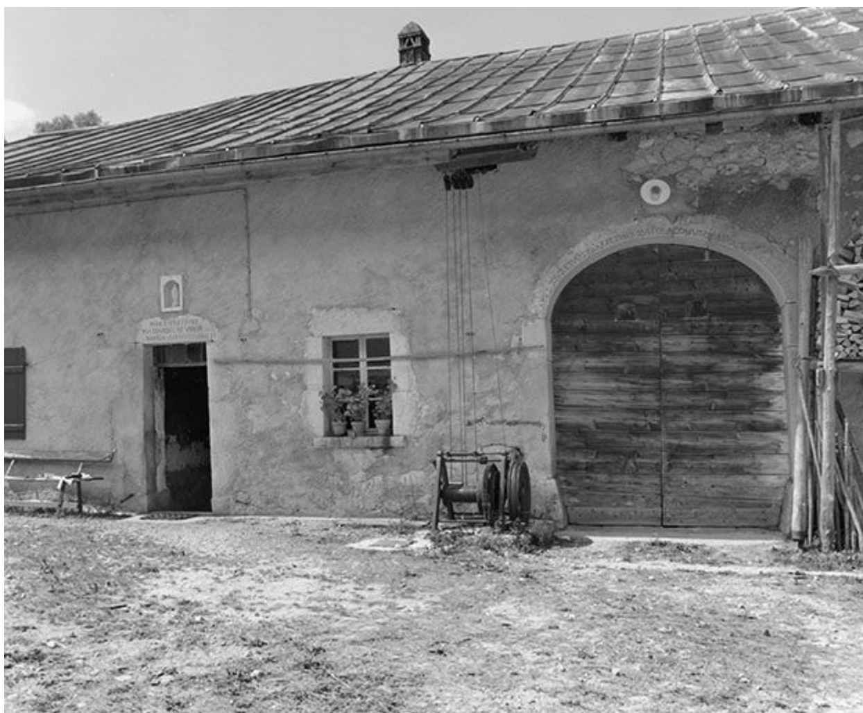
Les baies de la façade antérieure.
