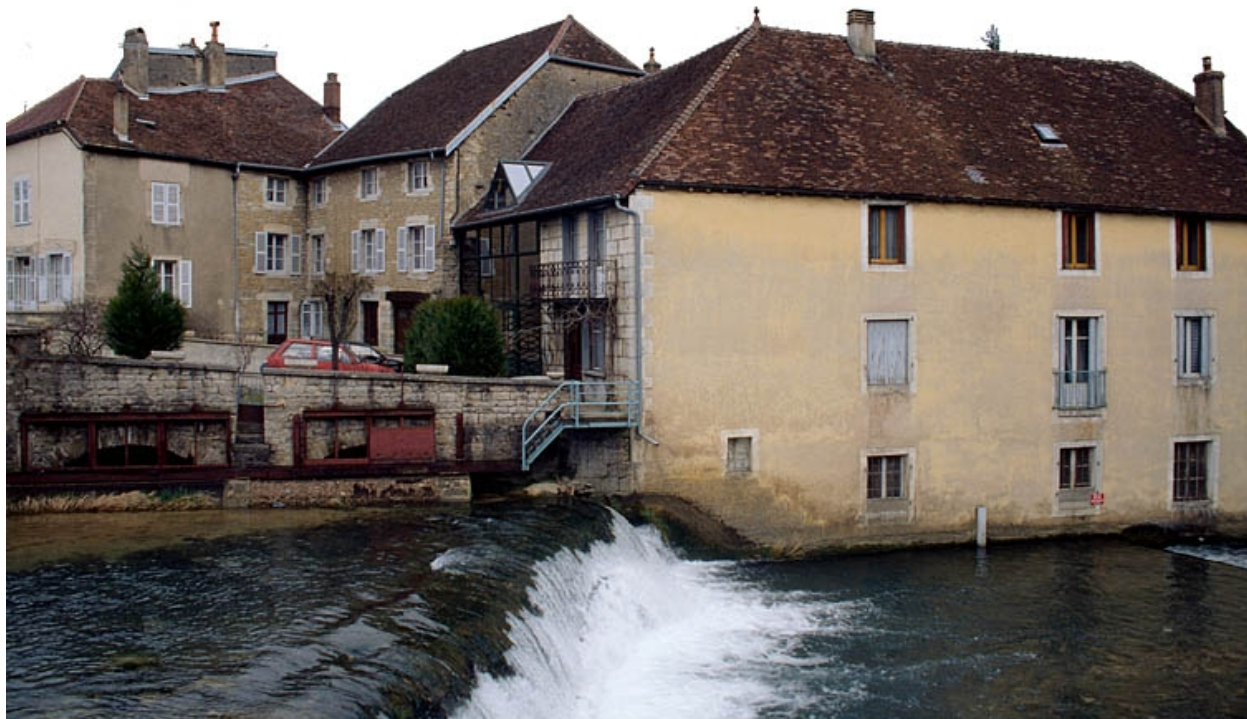
Vue d'ensemble depuis la rive droite.
