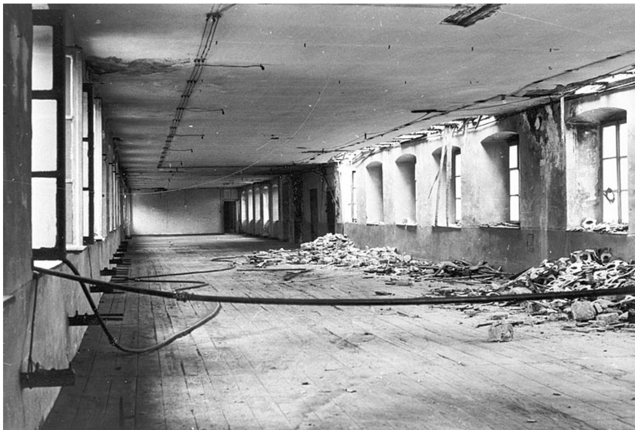
Atelier au second étage (état en 1978).
