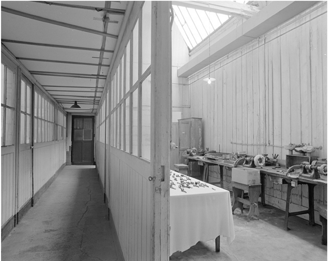
Atelier de vérification ouest.
