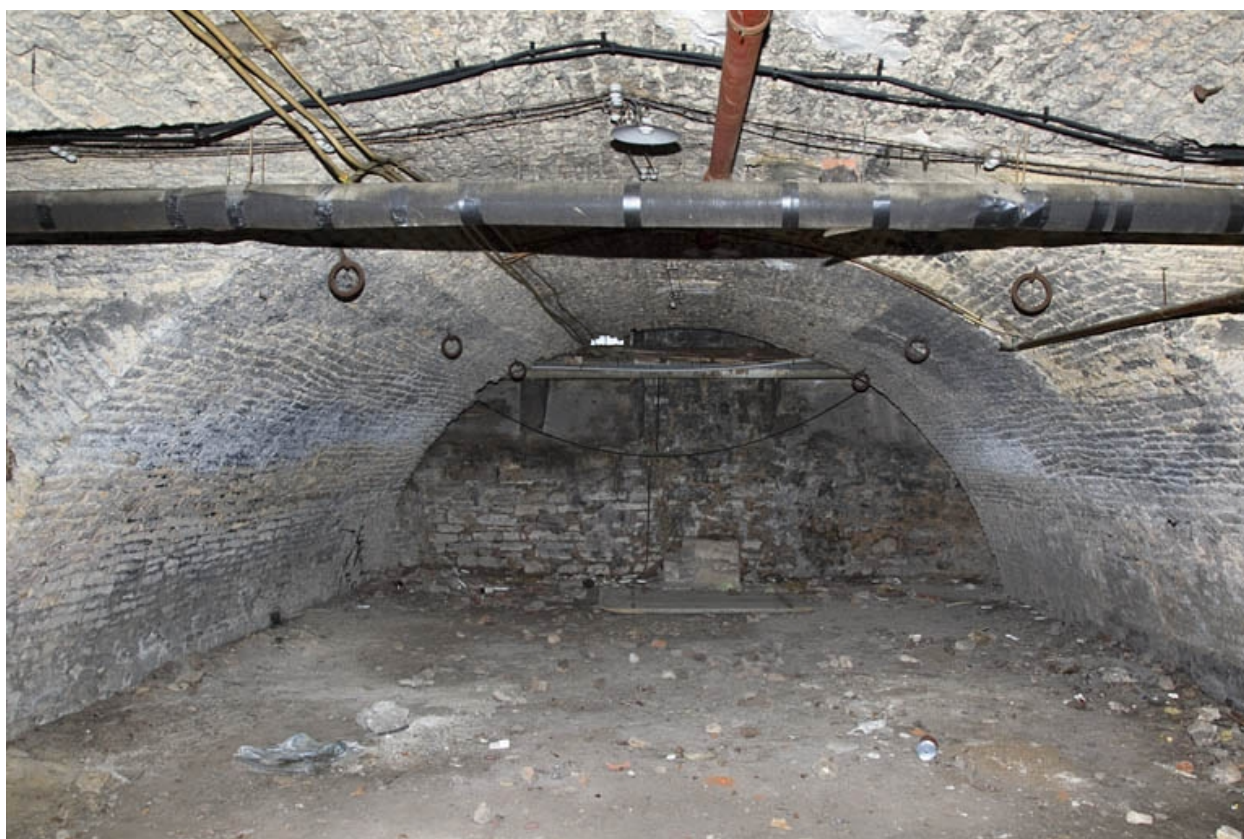
Sous-sol : détail d'une cave voûtée en berceau.
