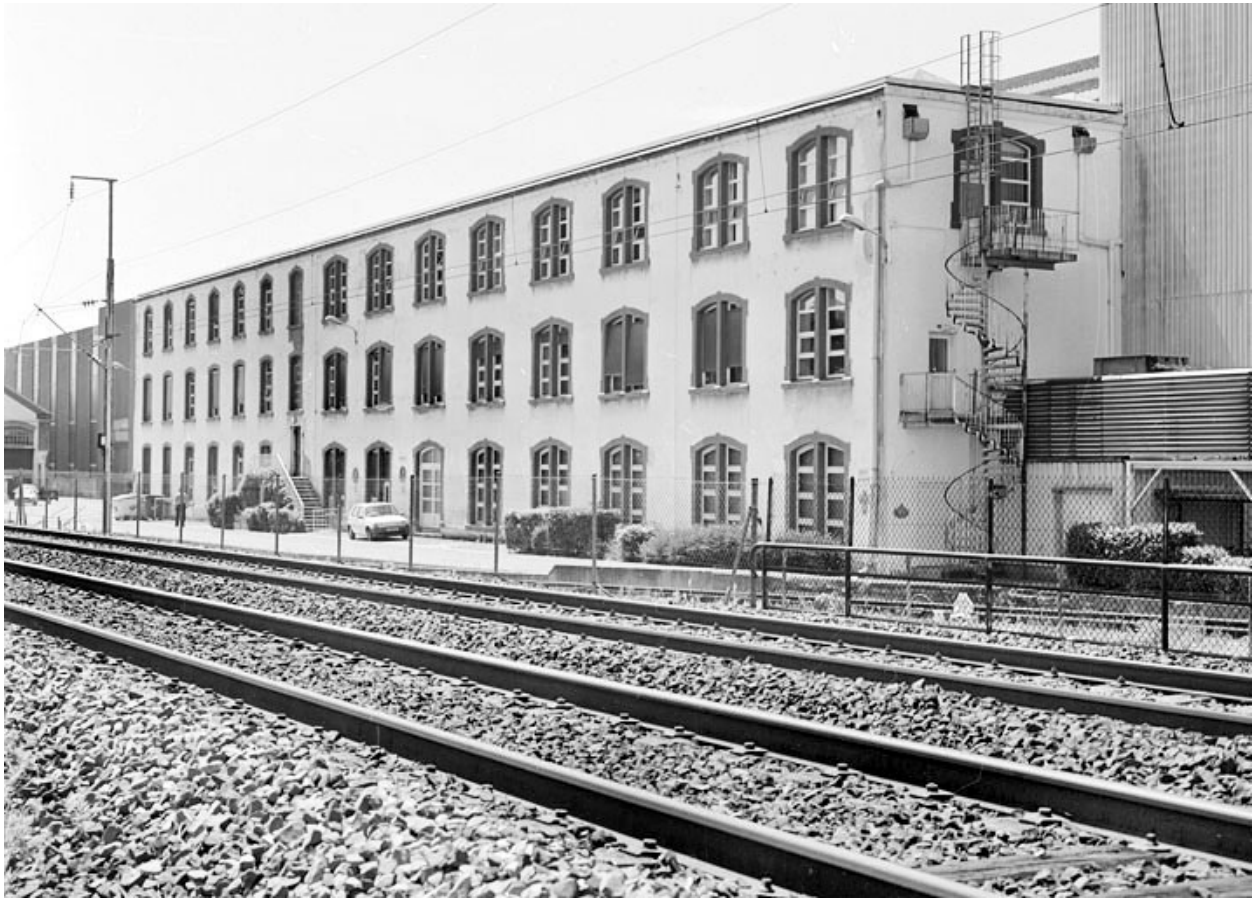
Façade est de l'ancien centre d'apprentissage.
