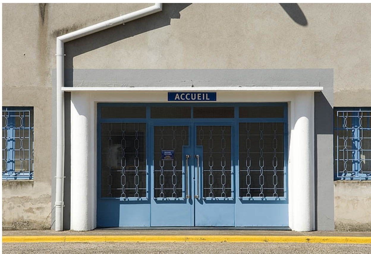
Façade des bureaux. Détail de l'entrée.
