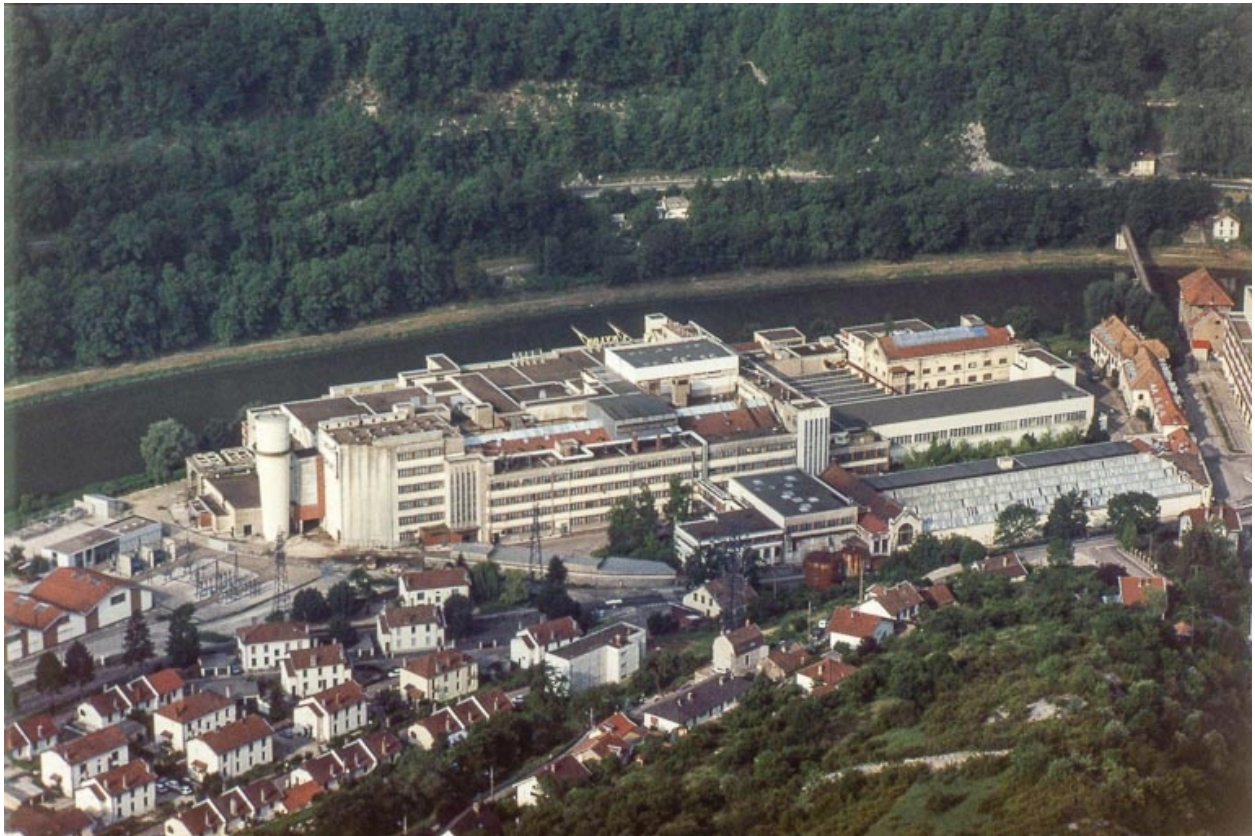
Vue aérienne de l'usine A depuis le nord-est.
