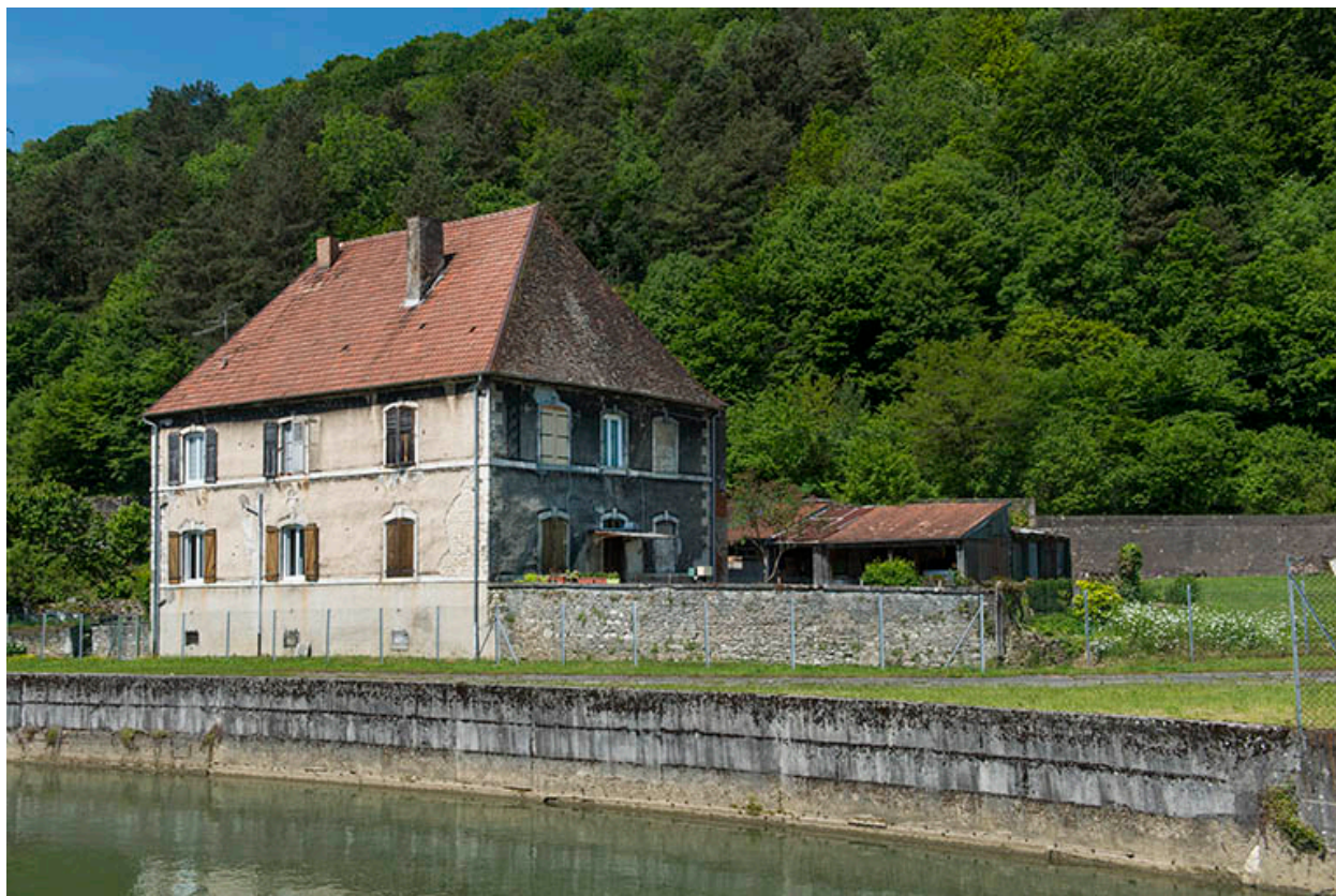
Bief d'amenée et logement patronal.
