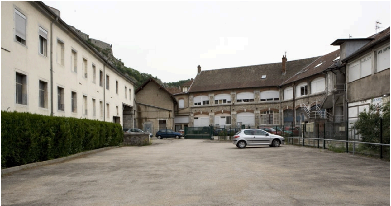
Cour, depuis l'amont.
