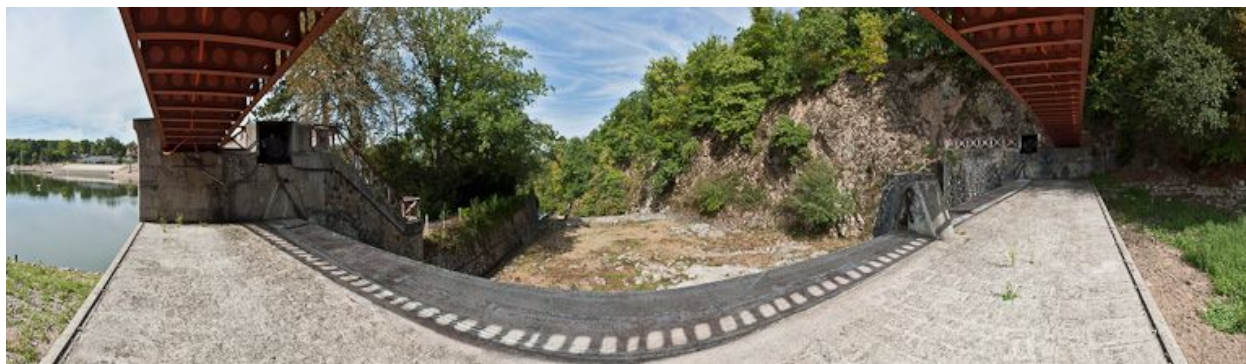
Vue du déversoir.
