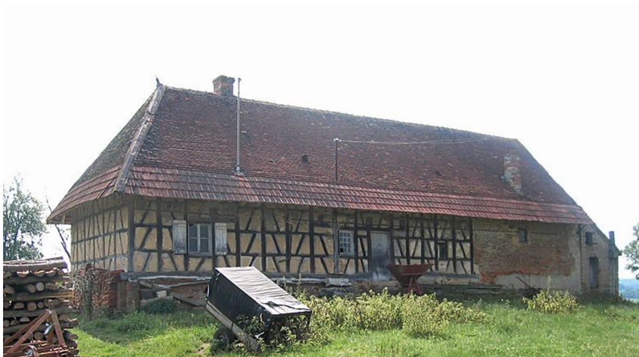
Vue d'ensemble de la façade.
