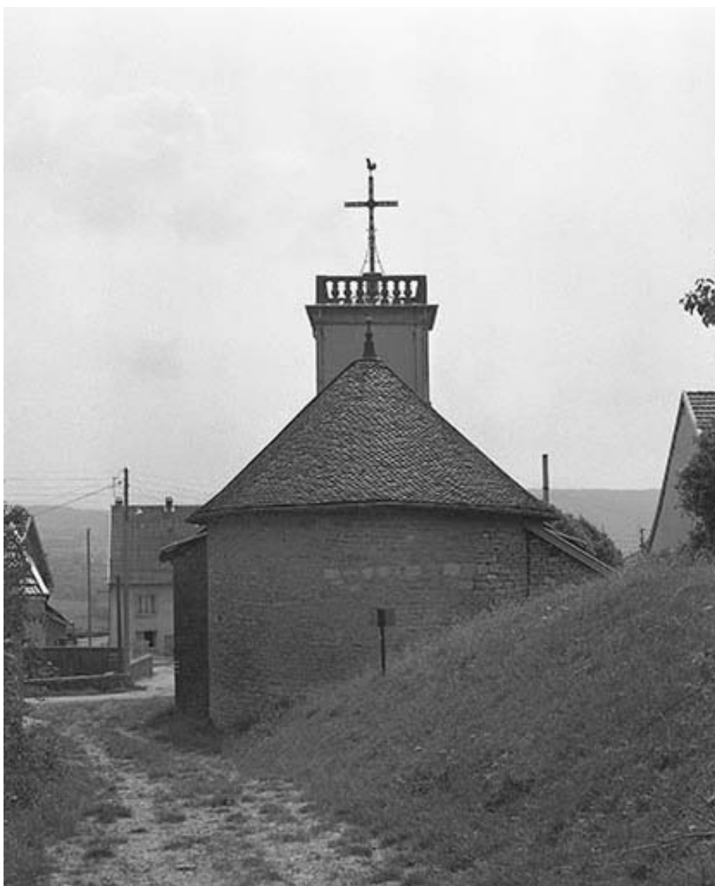
Extérieur : abside, vue de face.
