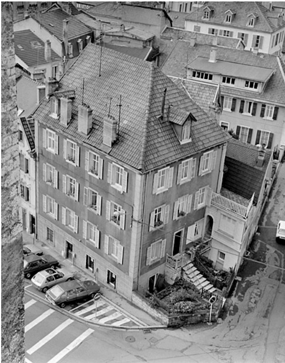
Immeuble 49, rue de la Mouche. Fin 19e siècle.
