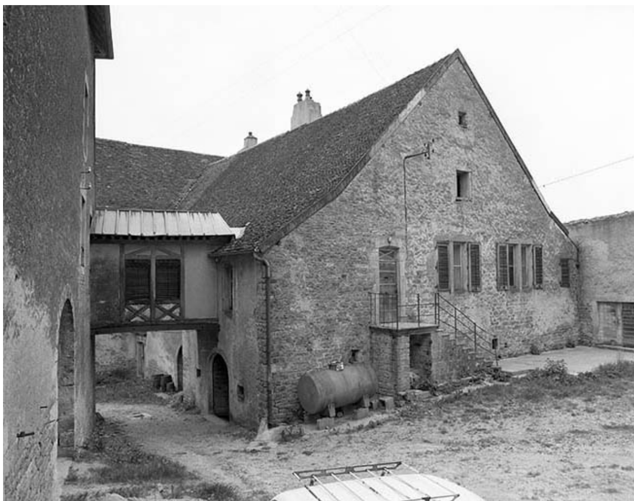
Façade est, partie droite.
